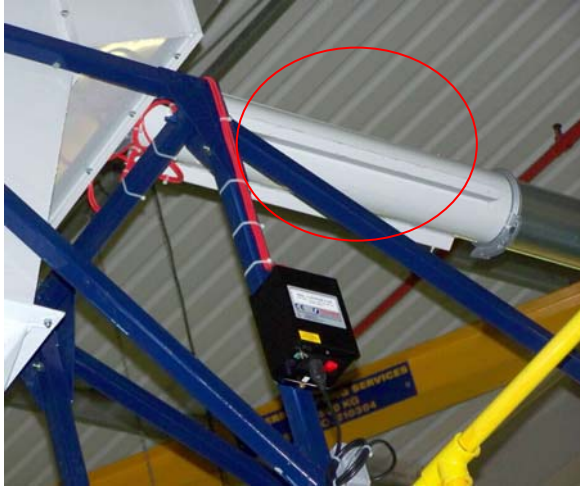
6000 离子管安装在分离器的上游
