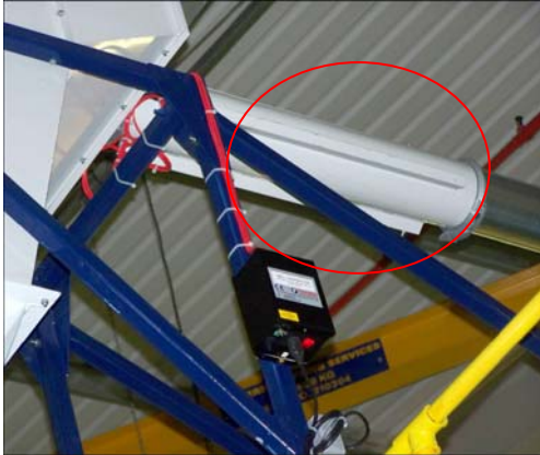
6000 离子管安装在分离器的上游
